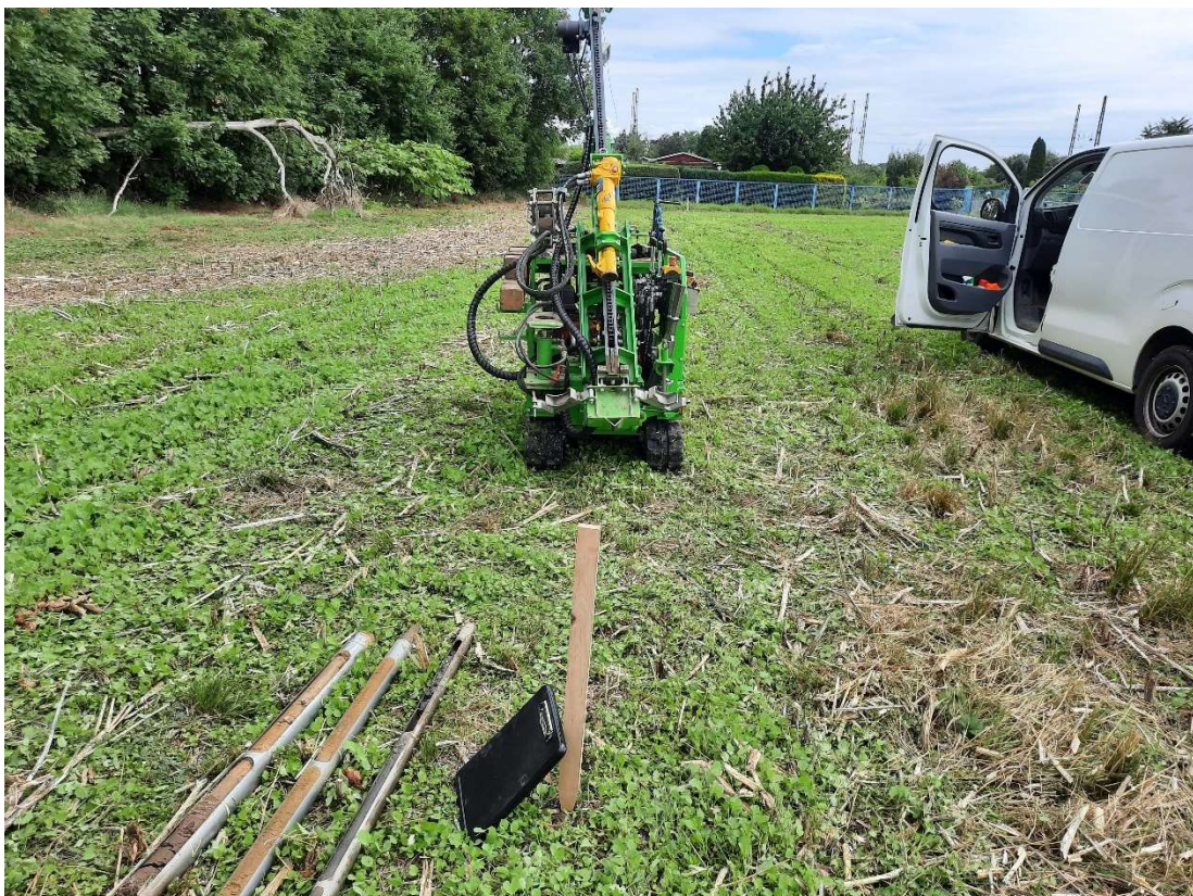
Bild 4: Sondierdraupe bei RKS 4, beispielhaft
