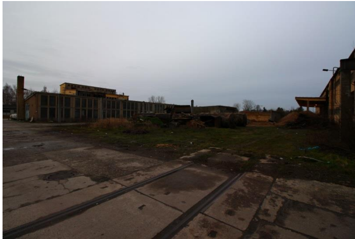
Abb. 2: Fabrikinnenhof, südlicher Abrissbereich für Ein- Mehrfamilienhäuser
