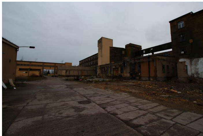
Abb. 1: Fabrikinnenhof Richtung Betriebseinfahrt, Sanierungsbereich
