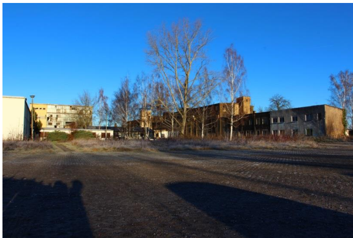
Abb. 4: Blick von südlicher PKW-Stellfläche Richtung Fabrik (nördlich)
